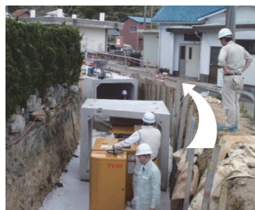
老朽化した既設構造物（下水道）の内部にボックスカルバートを搬送して補強（長寿命化）
