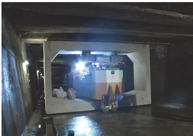
老朽化した既設構造物（下水道）の内部にボックスカルバートを搬送して補強（長寿命化）
