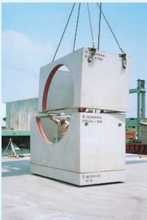
③直壁据付
