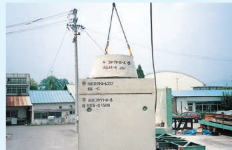
⑤円形1号斜壁据付
