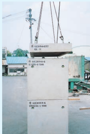
④スラブ・直壁据付
