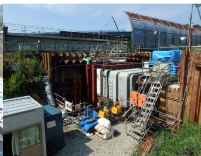
写真-2 推進状況
