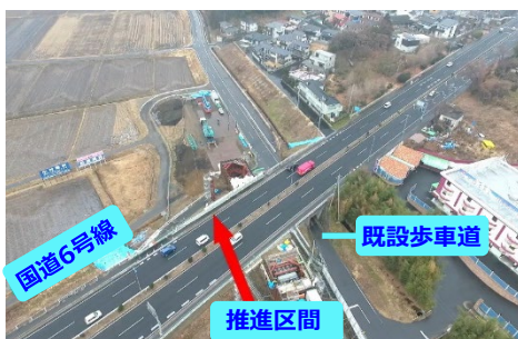
写真-1 上空からの現場状況
