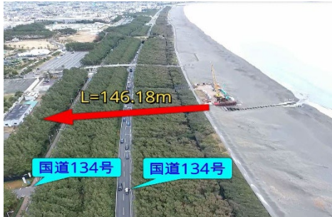
写真-1 上空からの現場状況
