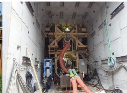
写真-3 製品内部の排土状況
