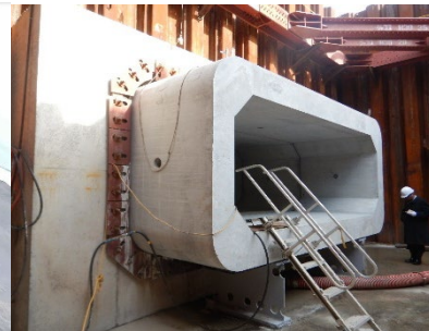
写真-2 発進側（海側）
