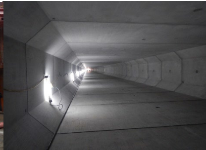
写真-3 内部状況
