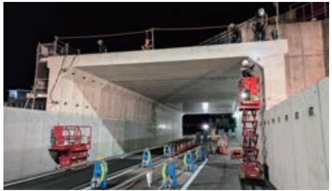
当社主力製品のPCボックスカルバートは、地下に埋設される箱型のコンクリート構造物（耐震構造）で、下水道、雨水排水路、農業用水路、地下道、共同溝、雨水貯留槽などで活躍しています。
