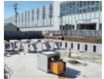
駅前に雨水貯溜槽を構築 製品を無騒音（CO 2 排出ゼロ）で搬送するECO-C・L工法
