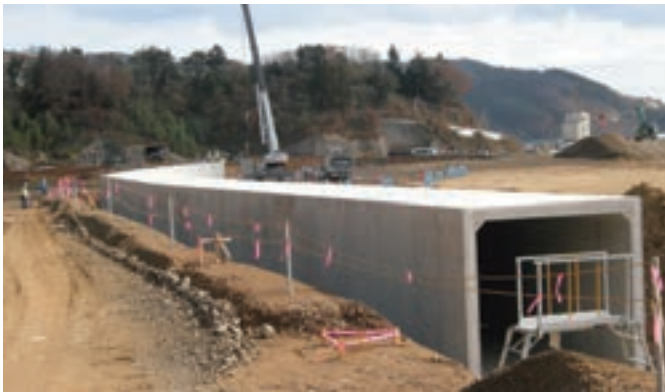
当社主力製品のPCボックスカルバートは、地下に埋設される箱型のコンクリート構造物（耐震構造）で、下水道、雨水排水路、農業用水路、地下道、共同溝、雨水貯留槽などで活躍しています。
