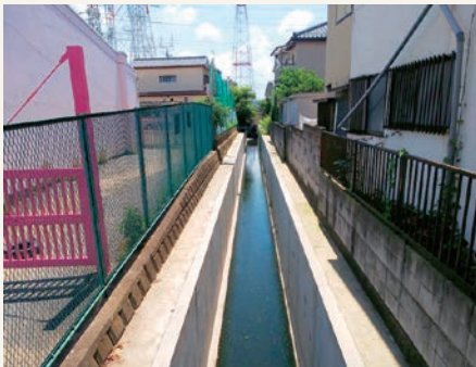
▲施工後（函体敷設完了）
