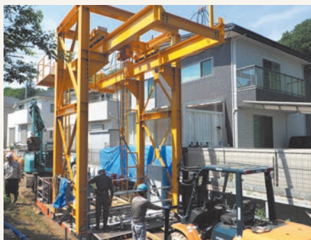
▲施工状況（函体運搬・据付け）
