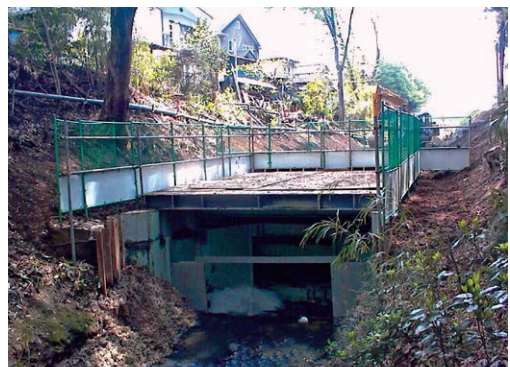
▲残置して新設函体内に放流が可能となります。
