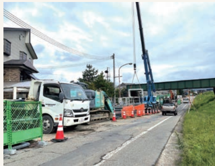
▲施工状況 (高架橋通過後)
