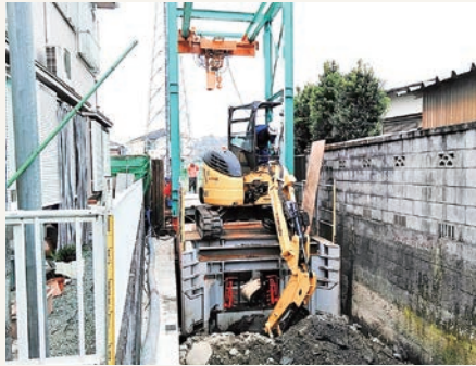
▲施工状況（切羽掘削）
