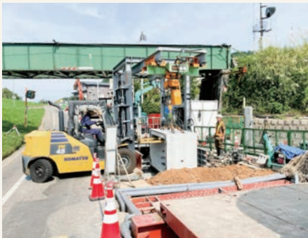
▲施工状況 (高架橋通過時)
