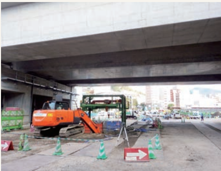
▲施工状況（切羽掘削）
