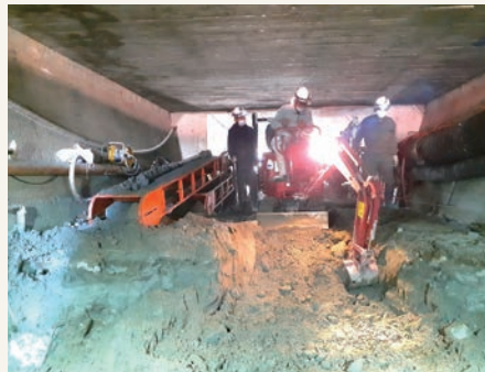
▲施工状況（切羽掘削）
