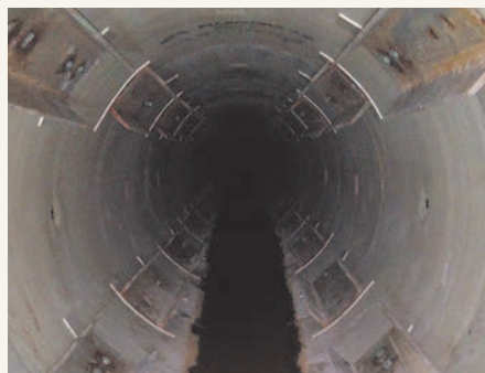
▲敷設推進管内
