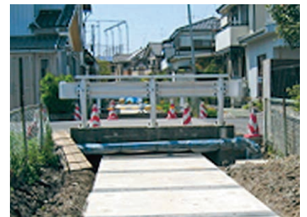
▲既設橋梁下横断
