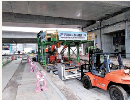
▲施工状況（函体下部運搬）
