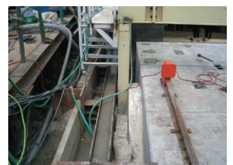
▲裏込注入状況
