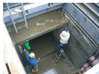
▲函体縦縮用PC鋼棒緊結状況
