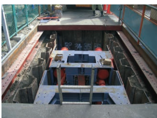
▲発進立坑内に組立てたオープンシールド機(NOS I 型)
