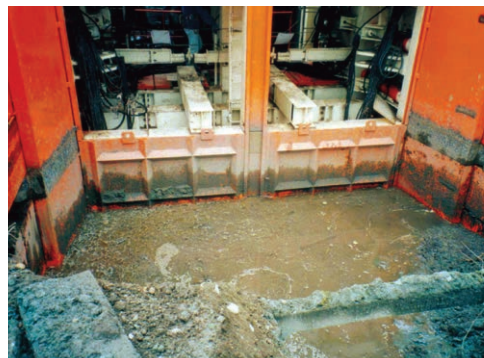
▼施工中のオープンシールド機(NOS I型)
