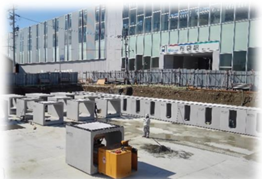
新ボックス型アグアへの適用例 (雨水貯溜槽) 1630m 3 (内幅1800×内高1500)
