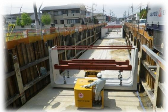
U型製品への適用例 (水路) 内幅 4700 × 内高 2400mm
