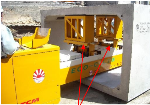
リフトアップ部
