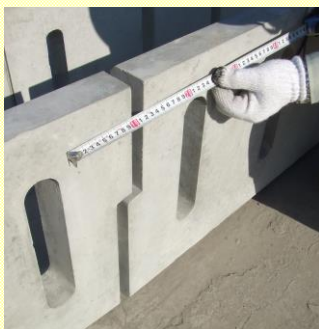
写真は、ジョイント部の隙間を20mm開けたときのカーブ付け状況 (R = 50m 相当)
