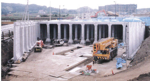
組立作業状況
