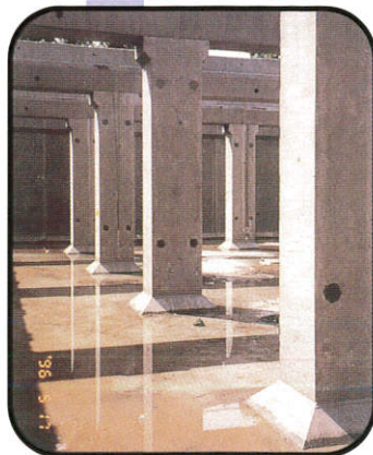
7. 底盤現場打コンクリート打設
