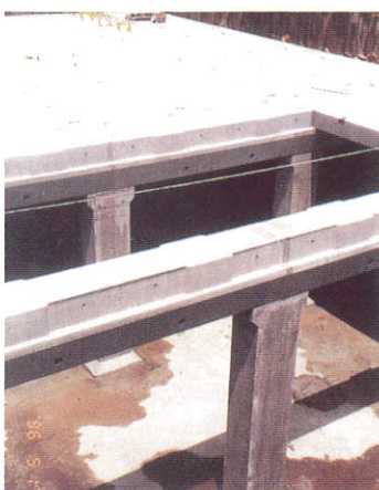
頂版スラブ据付け状況
