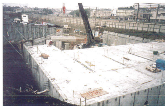
頂版スラブ据付け状況
