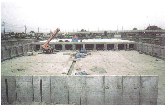
組立作業状況
