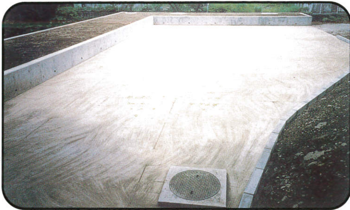
上部が駐車場の施工例
