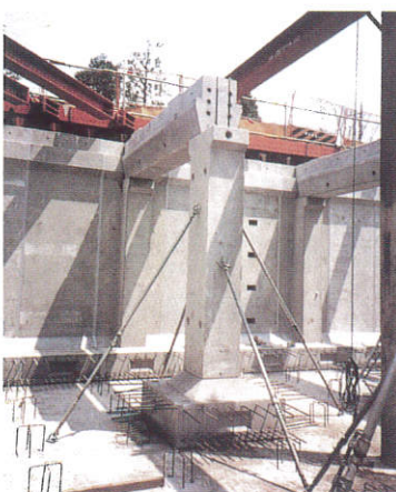
柱・梁据付け状況
