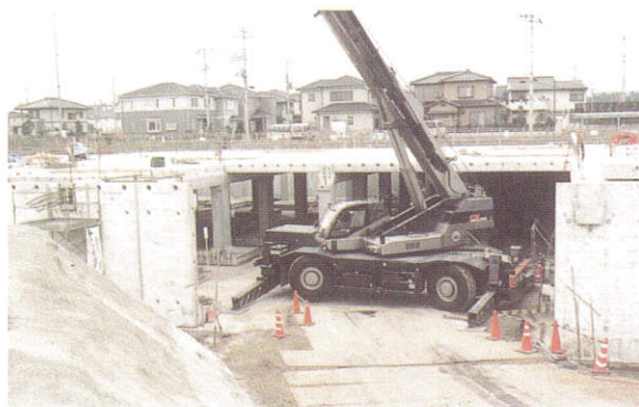
組立作業状況
