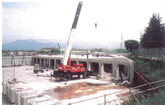
組立作業状況
