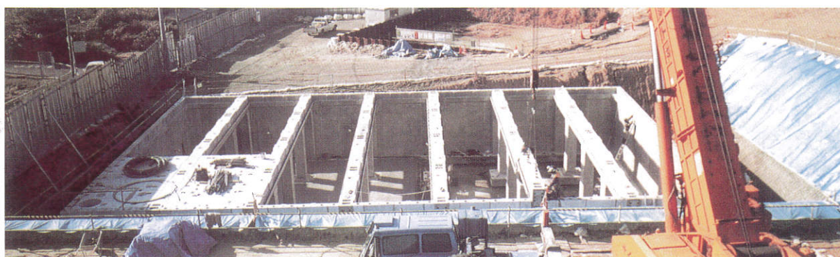
梁据付け状況
