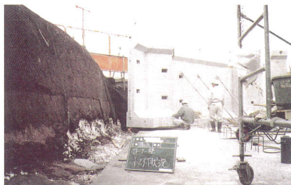
コーナー壁据付け状況
