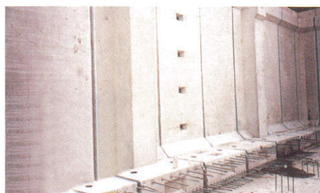
壁据付け状況
