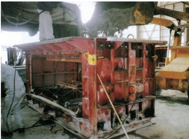
コンクリート打設
