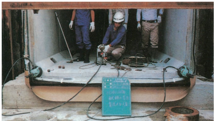
PC鋼棒による縦締め施工
