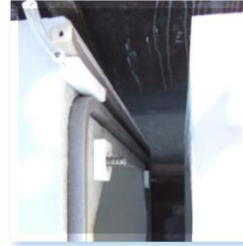
T Bジョイントバー挿入状況
