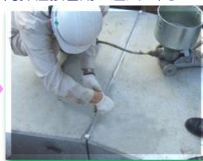
上部より頂版天端部へ注入
