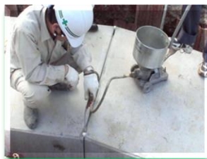
注入口より側壁部・底板部へ注入
