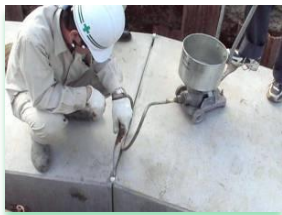
頂版から注入
