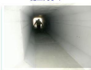
内部の状況 曲線部も直線部と同じ施工！
