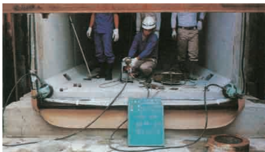
PC鋼棒による縦締め施工
