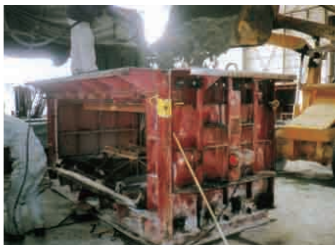
コンクリート打設
