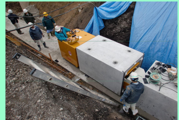
TB工法との組合せ施工
