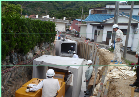
住宅地での施工（狭隘地・曲線部）
