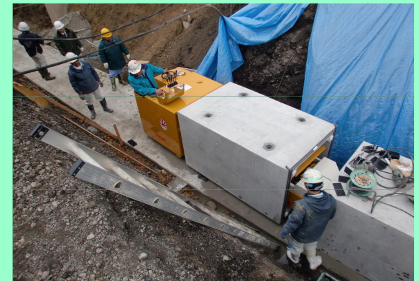
TB工法との組合せ施工
