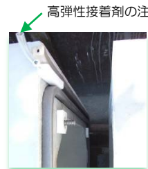
上面から下方を見る
