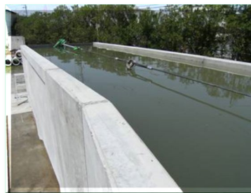
変位後の漏水なし
