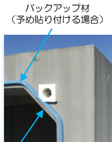
バックアップ材 (予め貼り付ける場合) 充填前 高弾性接着剤の充填部 (内目地)
